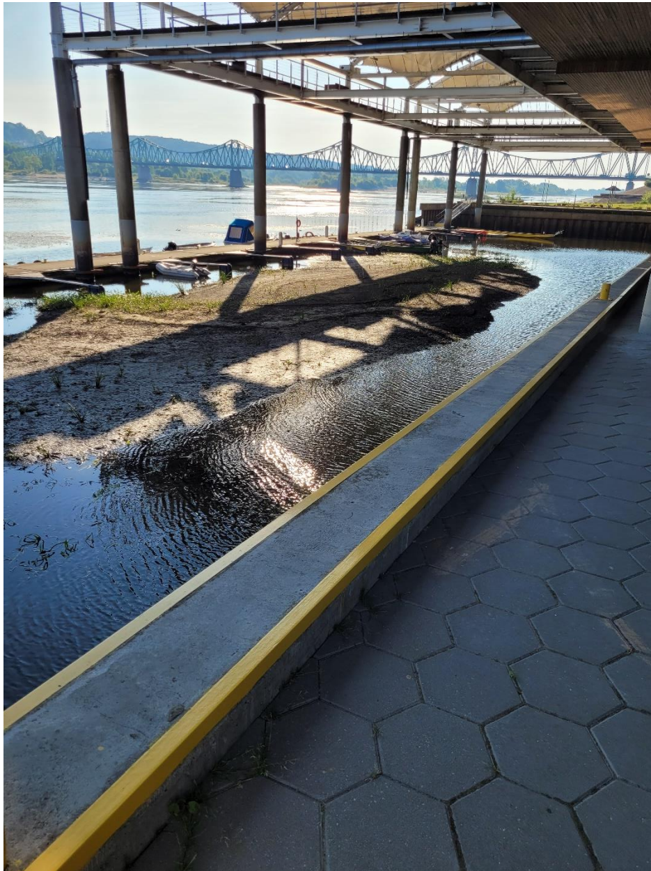
2. Widok basenu postojowego na długości przekrojów P-1 ÷ P-8.
