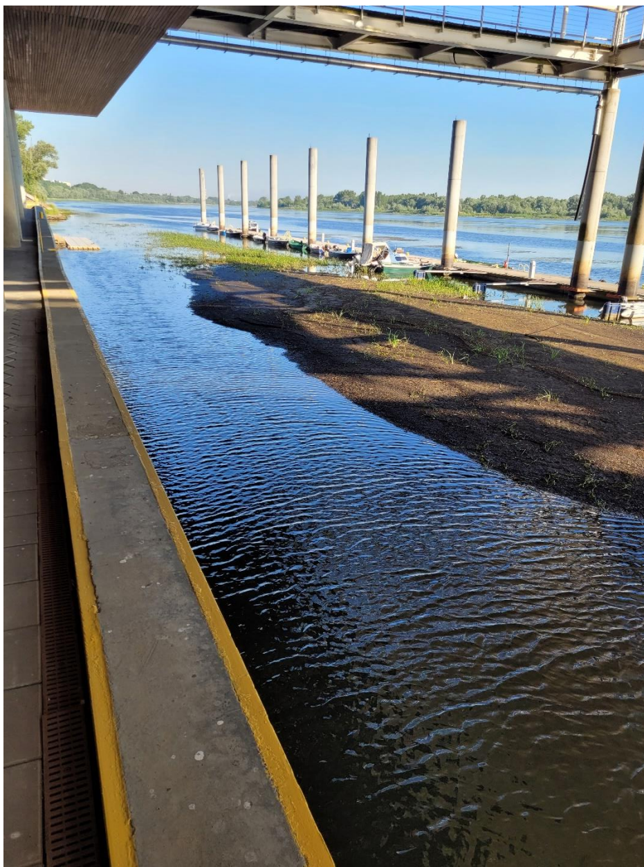
3. Widok basenu postojowego w kierunku przekroju P-18.
