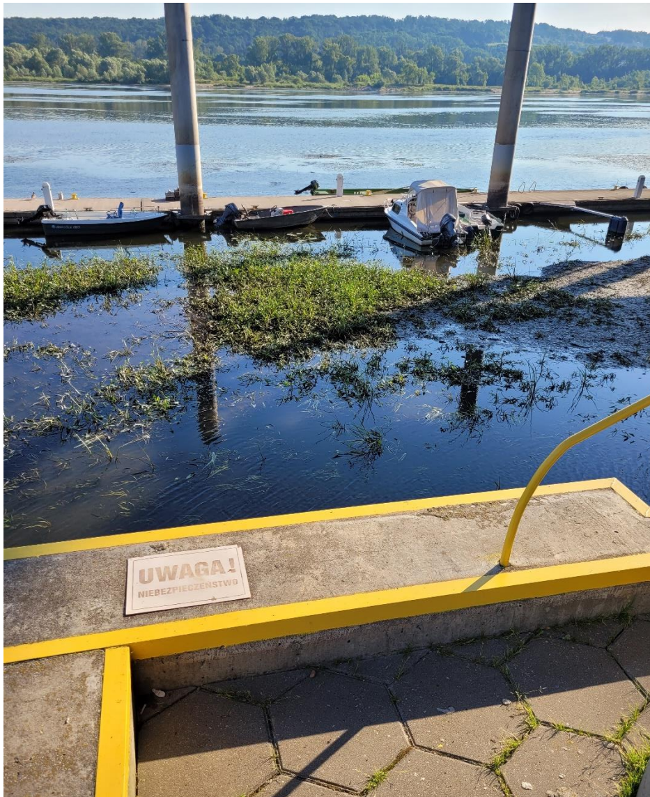
1. Widok basenu postojowego na wysokości przekroju P-9.
